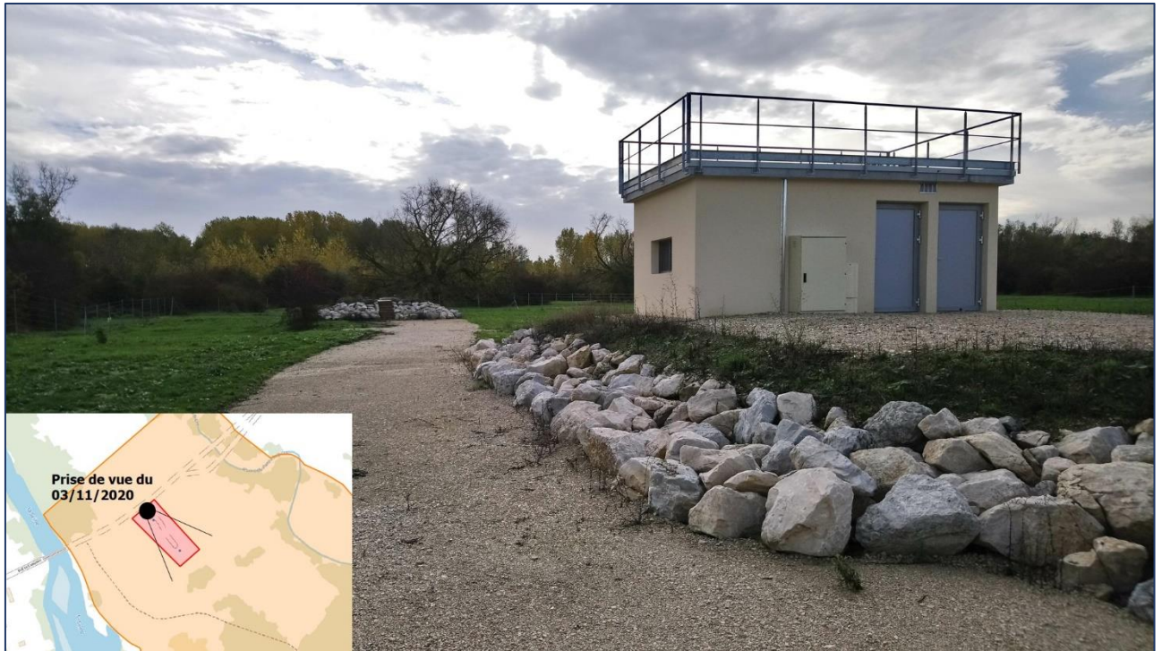
Figure 3 : Ouvrages de génie-civil (Fa au fond, Fb dans la station de pompage).
